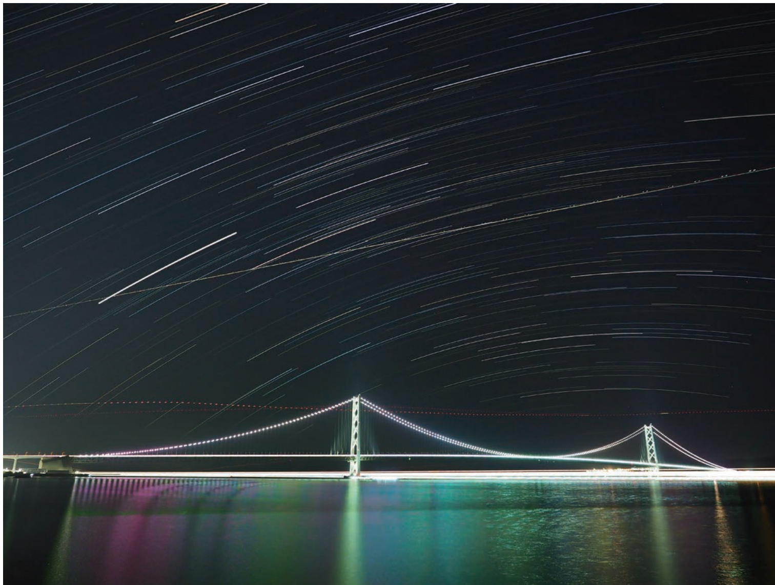
①OLYMPUS PEN-F、②M.ZUIKO DIGITAL ED 12-40mm F2.8 PRO、③F2.8、④2秒× 1,800コマ(ライブコンポジット機能を使用)、⑤ISO1600、⑥4000K、⑧三脚使用あり、 ⑨明石海峡大橋(大蔵海岸より撮影)
