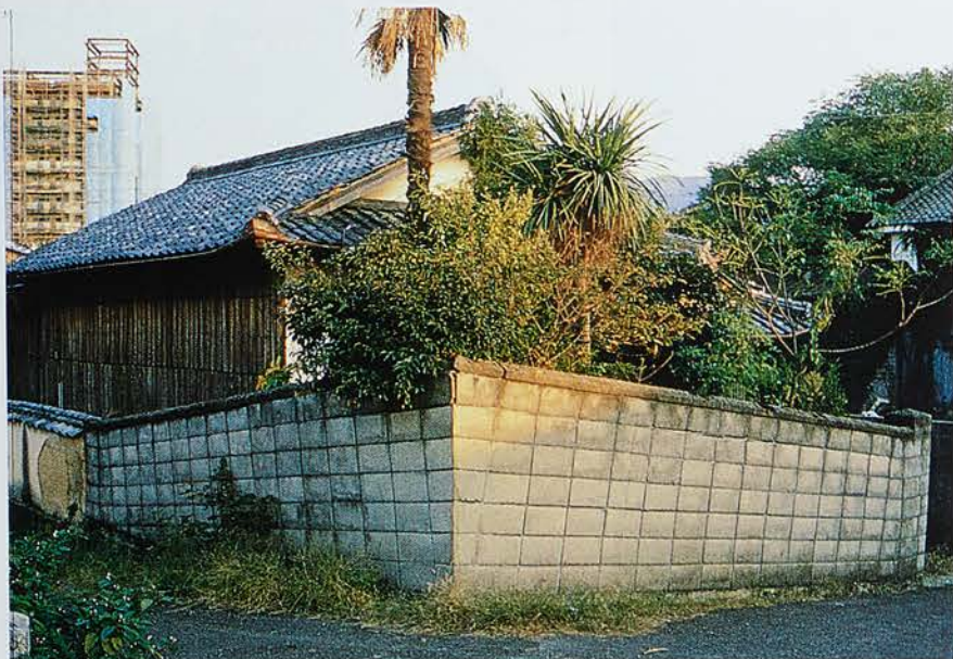
「立体派の塀」直角のブロックに斜めの坂道。角と角とが合わなくなり、ブロックを切って合わせたら、とんがって船の舳先みたいになった。屋敷がこれから船出するみたいだ。香川県の豊浜町にて。
