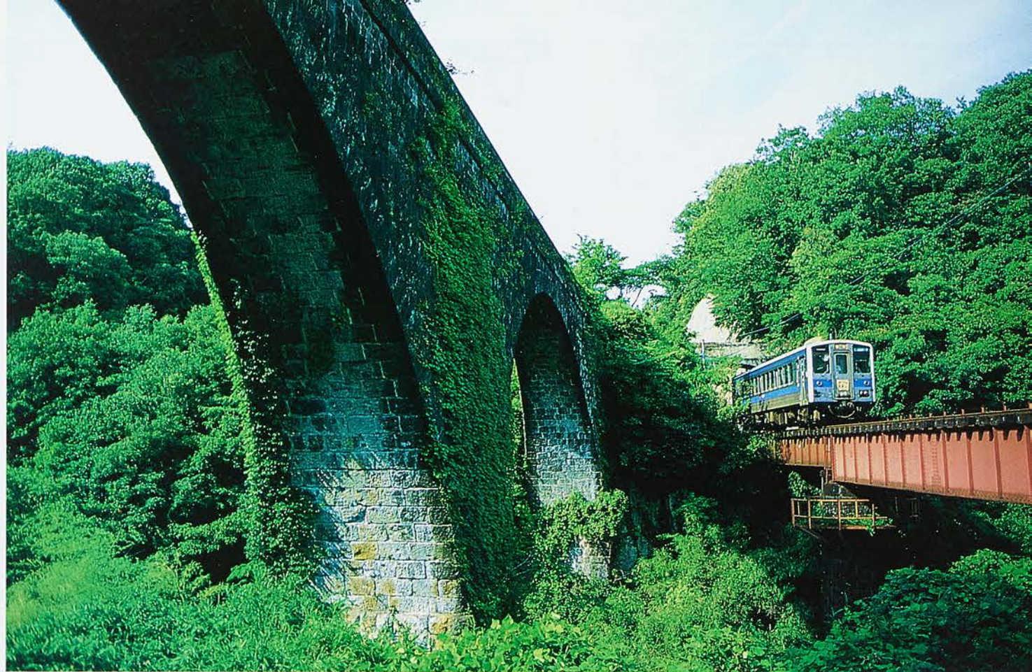
「笹無田若宮井路橋」(ささむたわかみやいろぎょう)鉄道の近くにかかる眼鏡橋は少ない。アーチ橋のそばを列車が走る姿はなかなか絵になる。 ■カメラ:キヤノンT90 レンズ:28mm 絞り:f4-5.6 シャッタースピード:1/250 フィルム:プロビア スカイライトフィルター使用 撮影地:大分県竹田市
