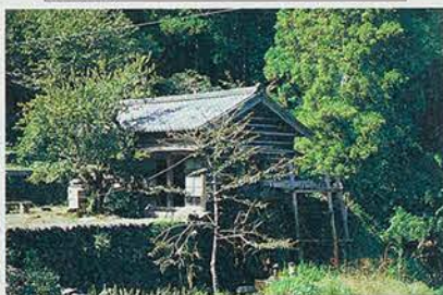
藤枝市 水車村 新緑の映える場所で、昔ながらの水車、吊り橋が復元され、子供にも安全なせせらぎがある。
